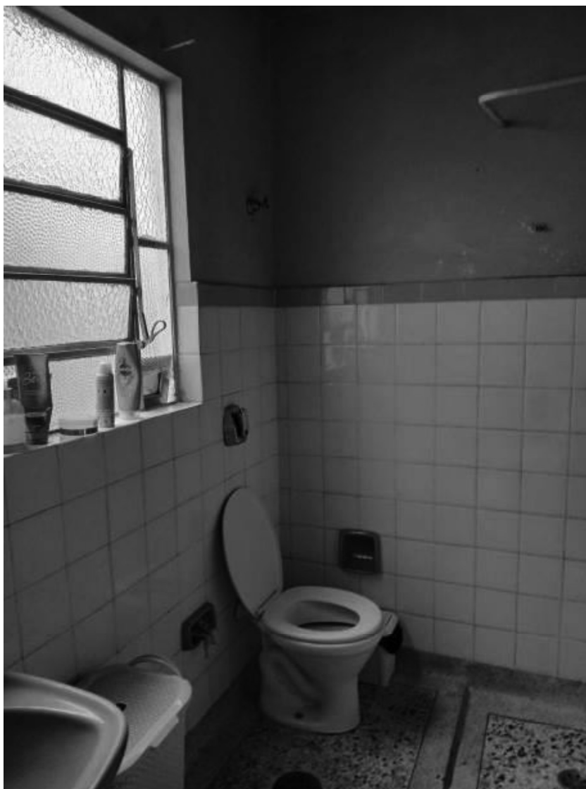
Detalhes de acabamento e conservação do banheiro.
