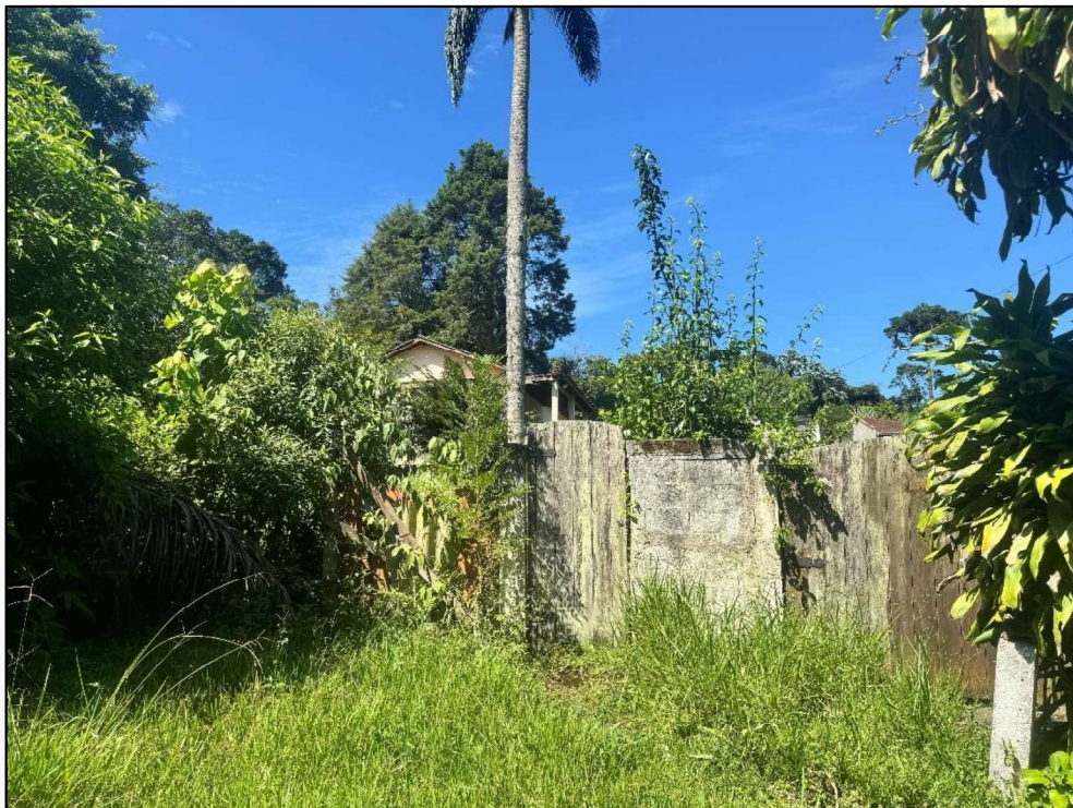
Foto 4 – Portões de acesso ao terreno.
