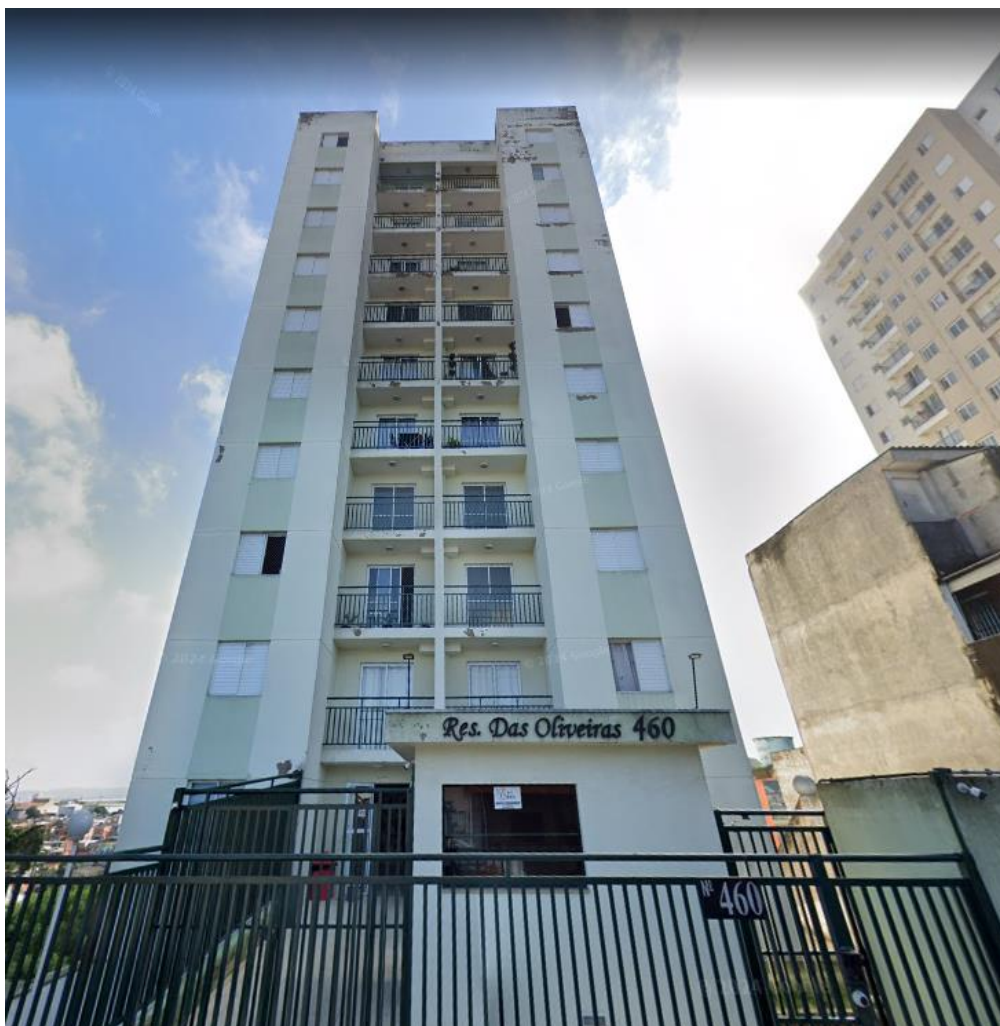
Vista Frontal do Edifício
