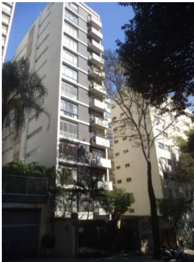
Vista parcial da fachada do edifício
