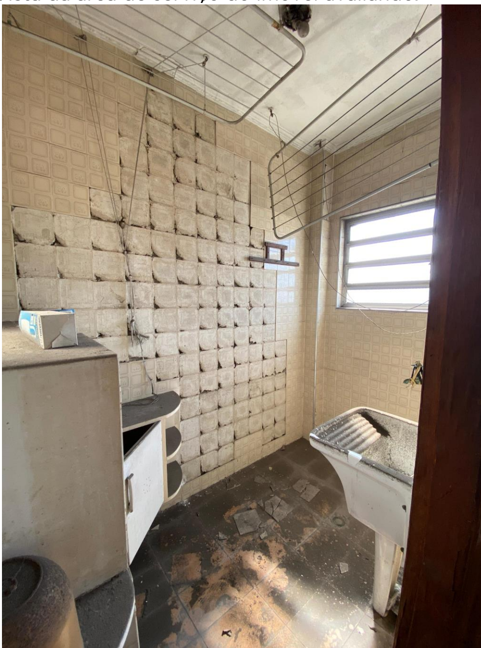
FOTO 5: Vista da área de serviço do imóvel avaliando.
