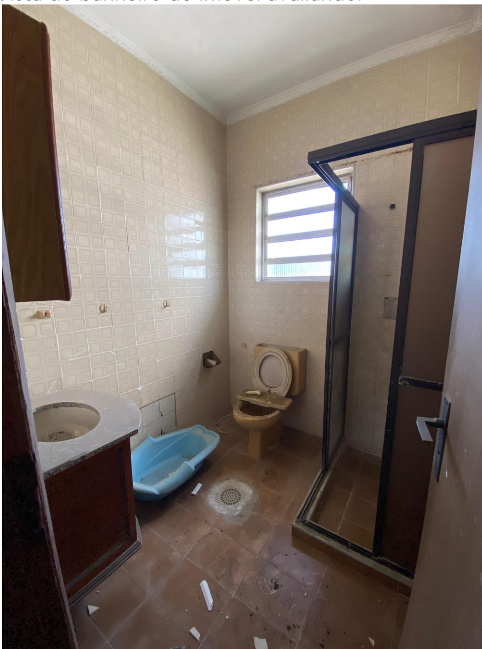
FOTO 11: Vista do banheiro do imóvel avaliando.
