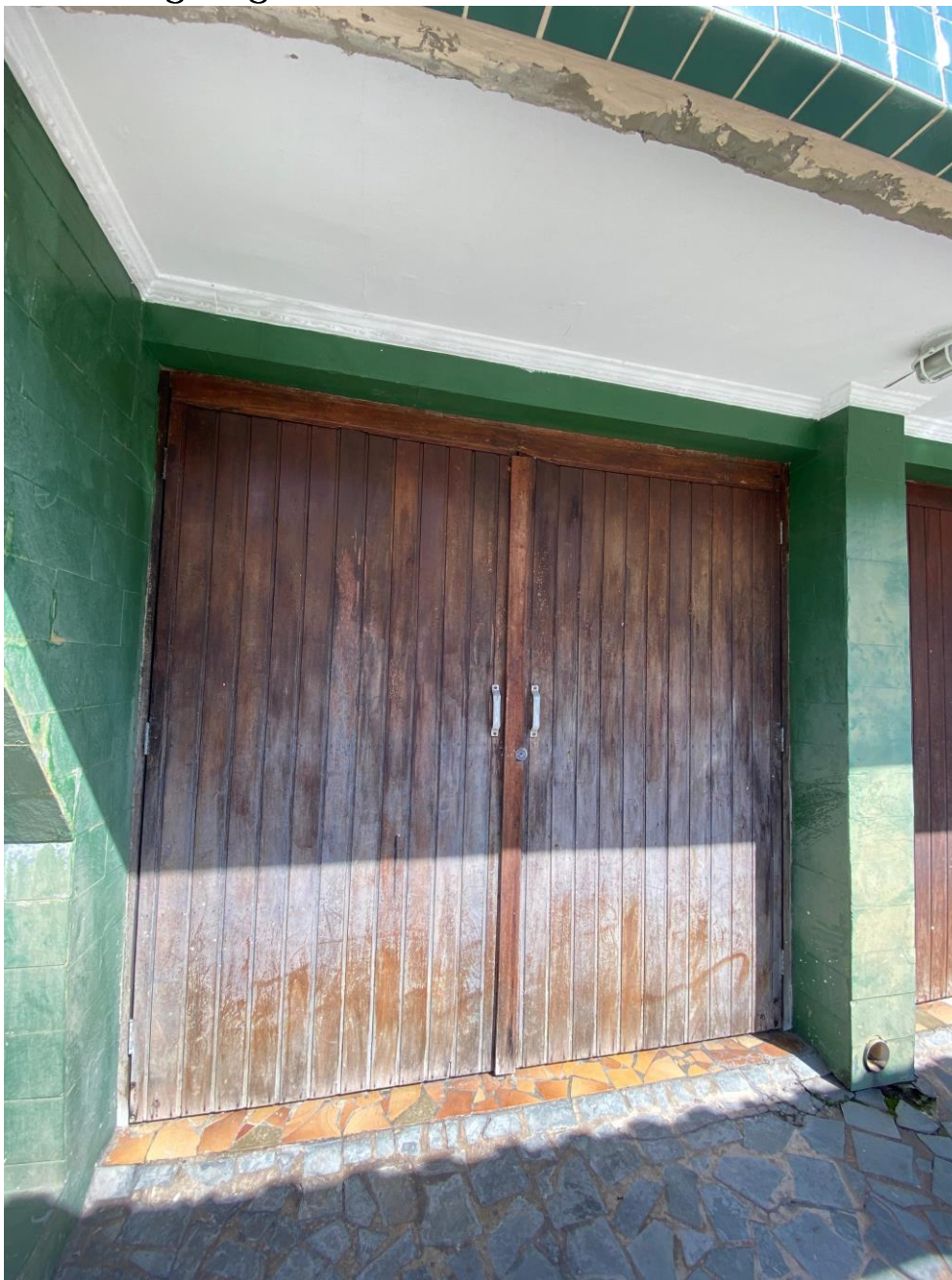
FOTO 12: Vista da garagem demarcada do imóvel avaliando.
