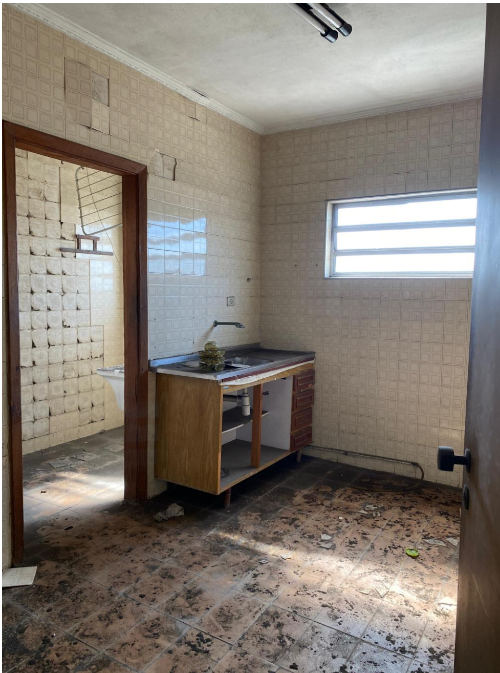
FOTO 4: Vista da cozinha do imóvel avaliando.
