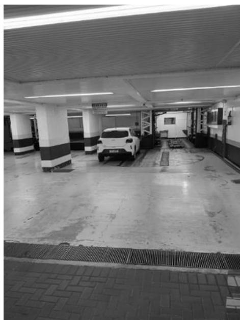
Acesso aos Boxes
