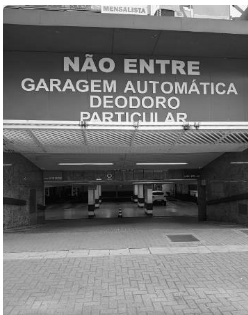
Fachada do Prédio
