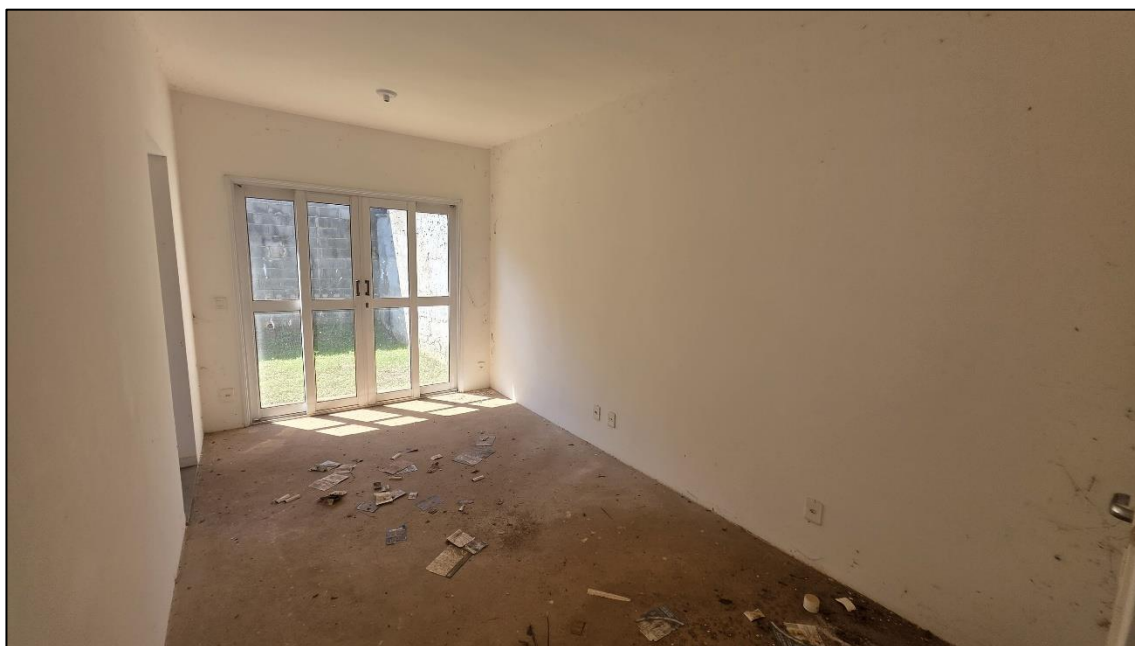
Imagem 13: Sala do imóvel no contrapiso, paredes e laje com reboco e pintura.
