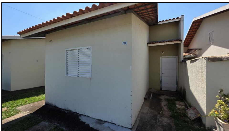
Imagem 11: Fachada da unidade autônoma vistoriada e número de identificação: 31 (trinta e um).
