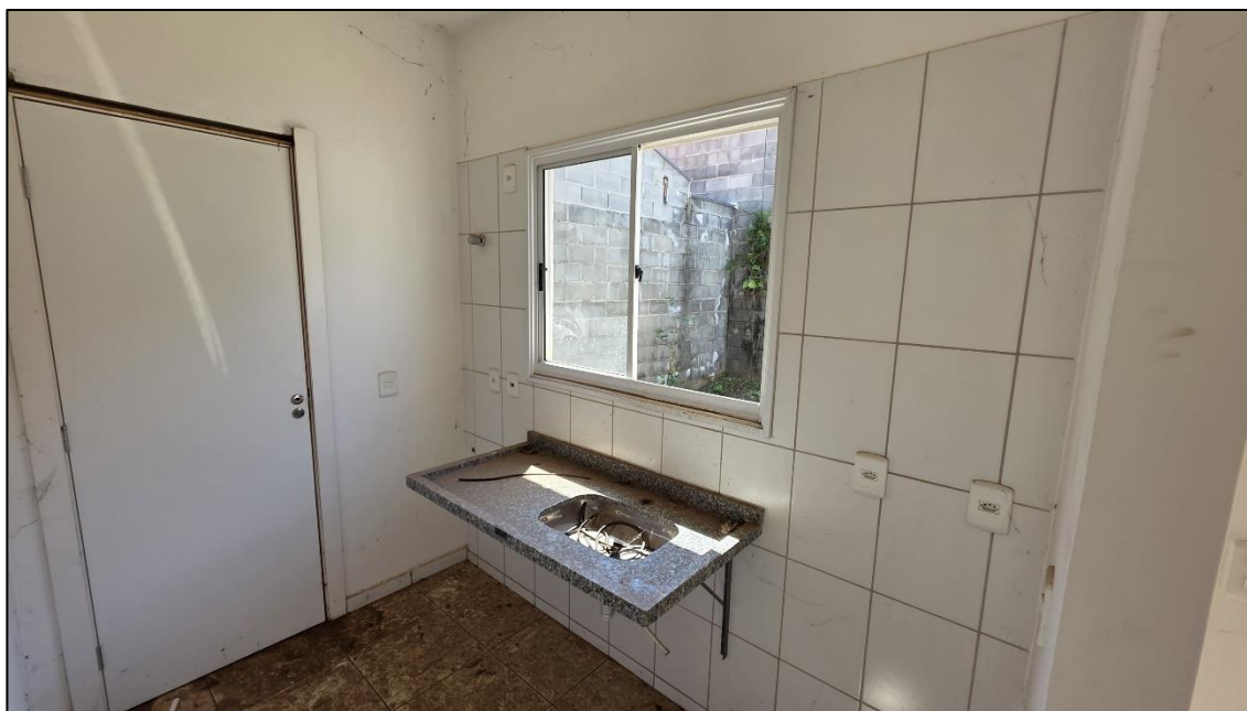
Imagem 15: Cozinha com piso e uma das paredes com revestimento cerâmico, demais paredes e laje com reboco e pintura.
