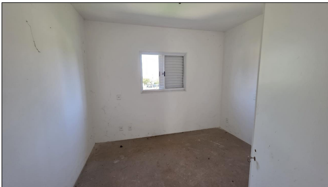
Imagem 19: Quarto 02 do imóvel no contrapiso, paredes e laje rebocadas com pintura.
