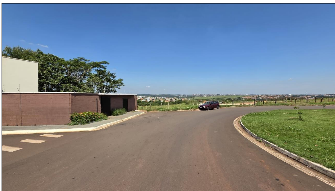
Imagem 06: Avenida Cabo Pedro Hoffmann (lado direito de quem olha de frente para o Condomínio Residencial Vivenda, onde se situa a unidade autônoma vistoriada).
