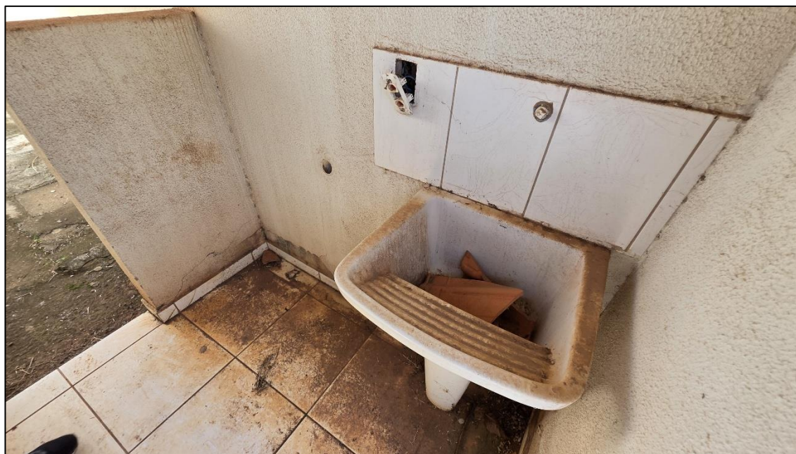
Imagem 22: Área de serviço com piso cerâmico e paredes com textura e pintura.
