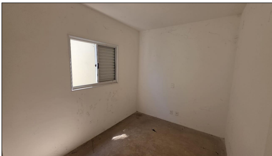
Imagem 17: Quarto 01 do imóvel no contrapiso, paredes e laje rebocadas com pintura.
