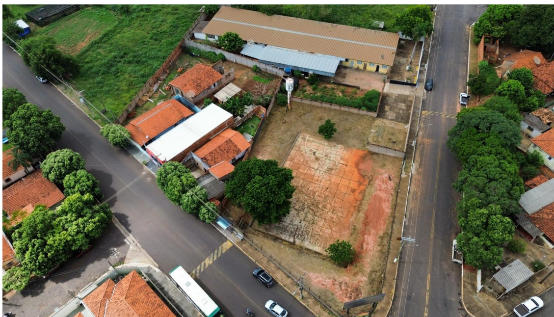
Fotografia 2 - Fotografia Aérea realizada por Drone - partes Edificadas do imóvel
