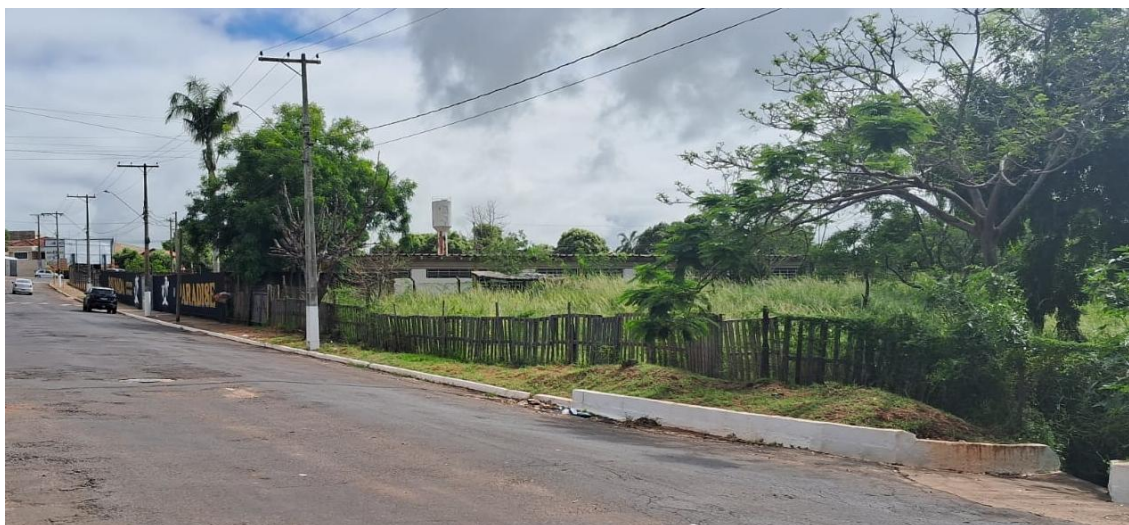
Fotografia 22 – Vista da Área não edificada do imóvel com dispositivo de Captação de Águas Pluviais
