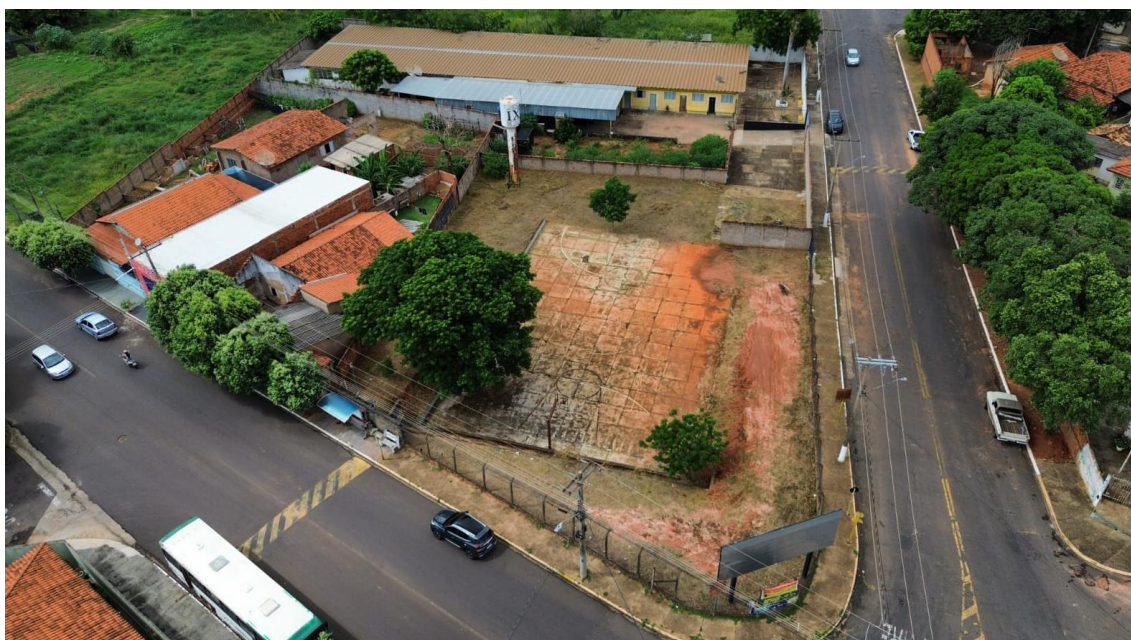
Fotografia 10 – Foto Aérea das edificações existentes no imóvel
