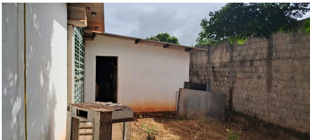
Fotografia 20 – Fundos da Edificação Principal
