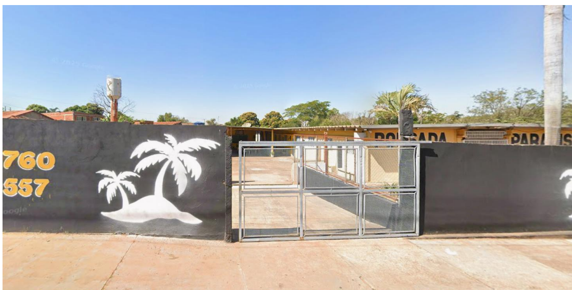
Fotografia 11 — Fachada da edificação
