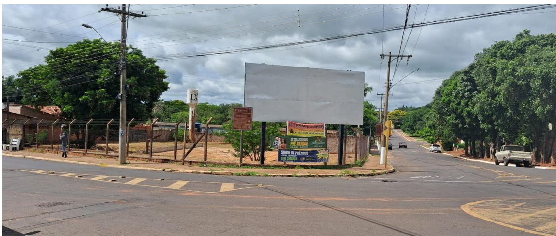
Fotografia 1 – Vista da edificação de quem olha da Rua 9 de Julho
