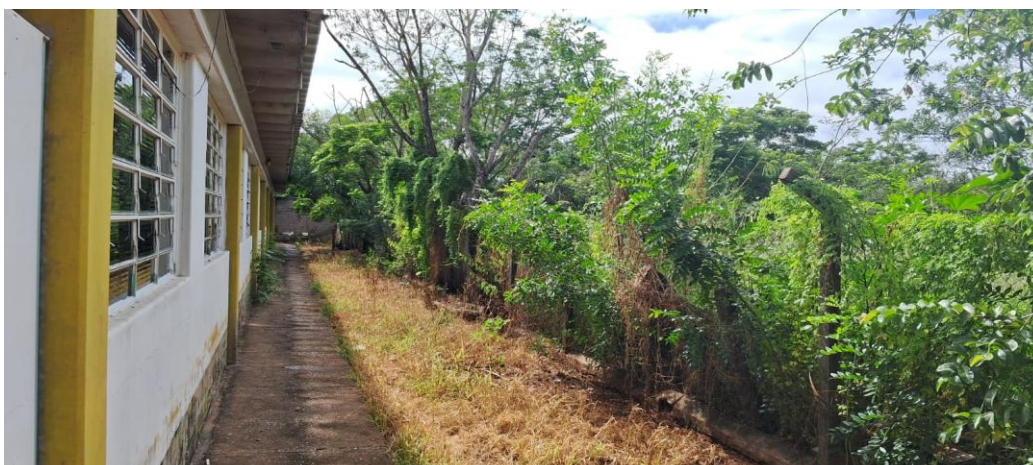
Fotografia 19 – Lateral Direita da Edificação Principal
