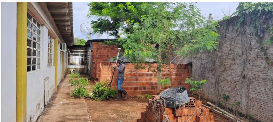
Fotografia 21 - Lateral Esquerda da Edificação Principal
