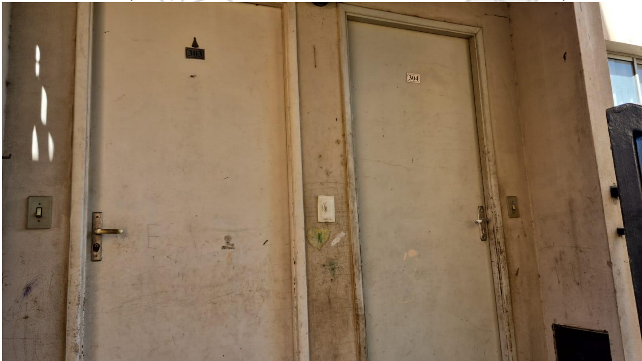
Foto 04 – Entrada do apartamento 304;
