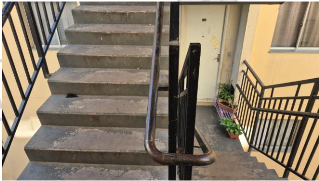
Foto 03 – Acesso ao terceiro andar;
