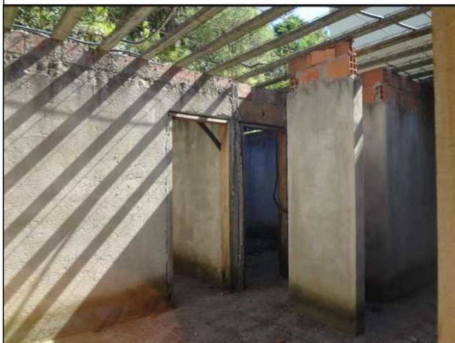
FOTO 19: Parte interna do lado esquerdo de quem entra no acesso à edificação.
