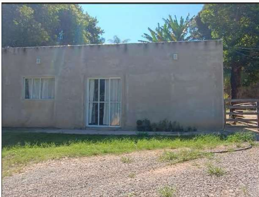
FOTO 76: Edificação de aproximados 66,00 m². Esquadrias frontais de alumínio e vidro. Parede emboçada.
