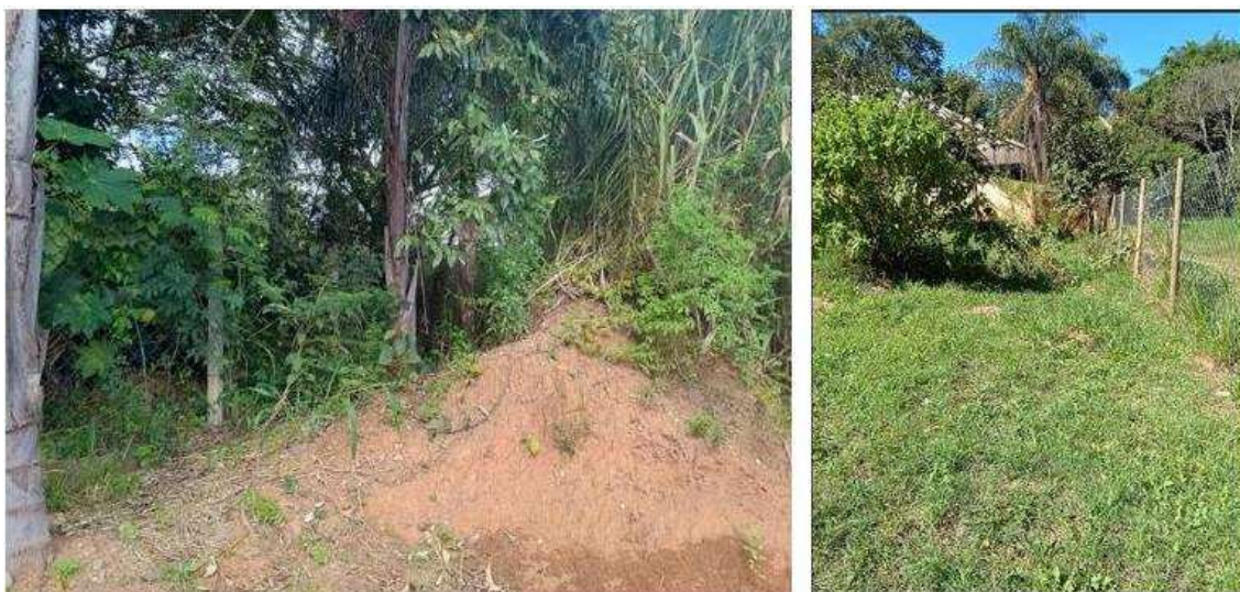
FOTO 68: Cerca externa e cerca divisória interna.
