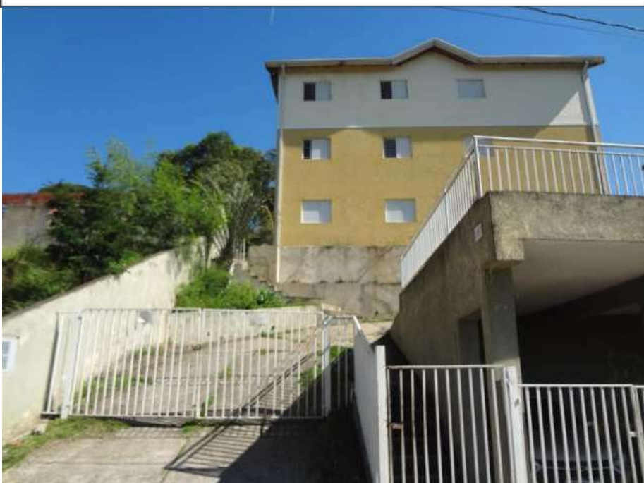
FOTO 27: Acesso frontal à área, social e de veículos.
