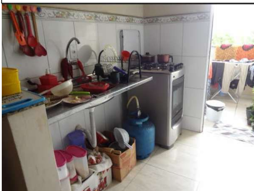
FOTO 59: Cozinha com revestimento cerâmico em ½ parede. Piso cerâmico. Pia em inox. Ausência de gabinete.
