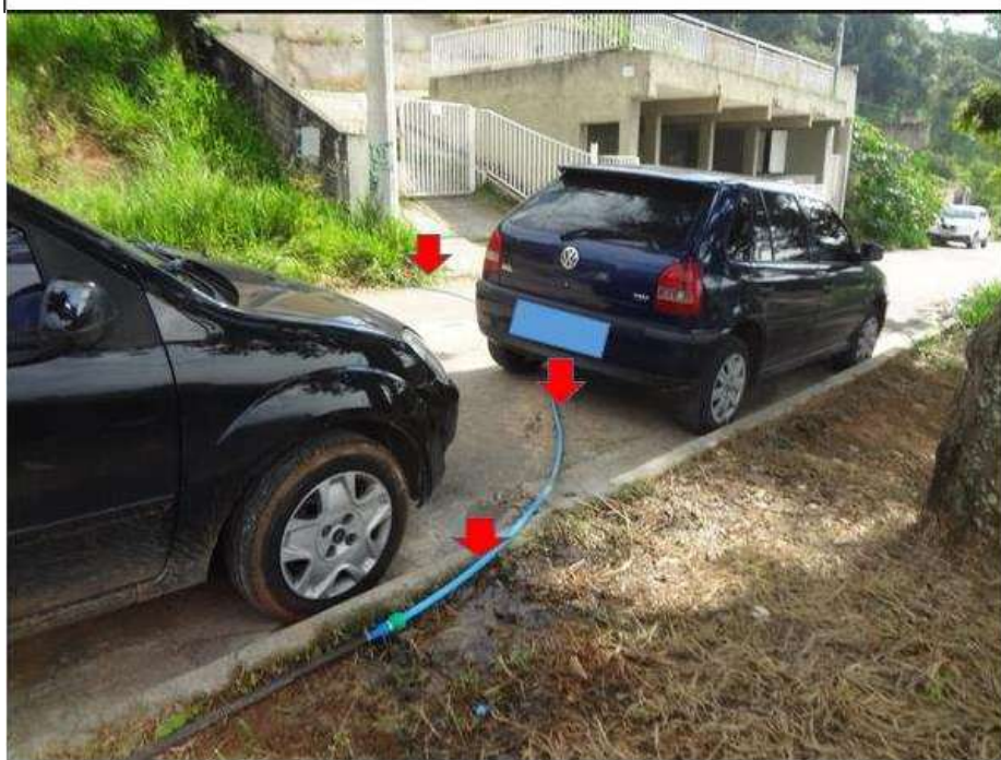
FOTO 37: Observado não haver abastecimento através do SAAE no prédio. A água é conduzida através de uma mangueira que abastece a caixa de água.
