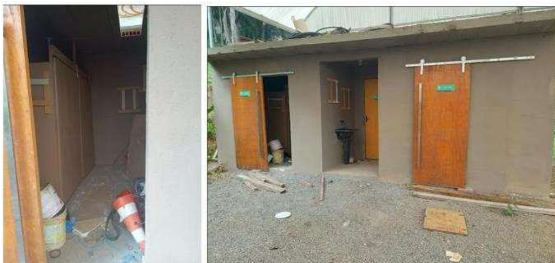
FOTO 73: Divisórias internas em aglomerado de madeira.
