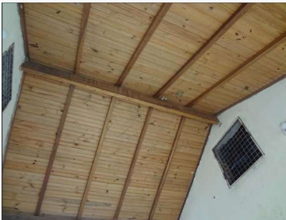
FOTO 34: Vista do forro do telhado que interliga os dois Blocos.
