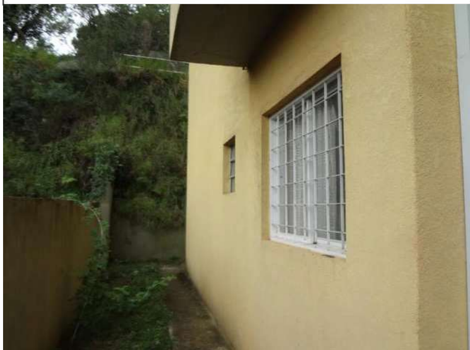
FOTO 31: Vista da lateral esquerda de quem de frente olha, da unidade edificada no térreo, segundo Bloco.
