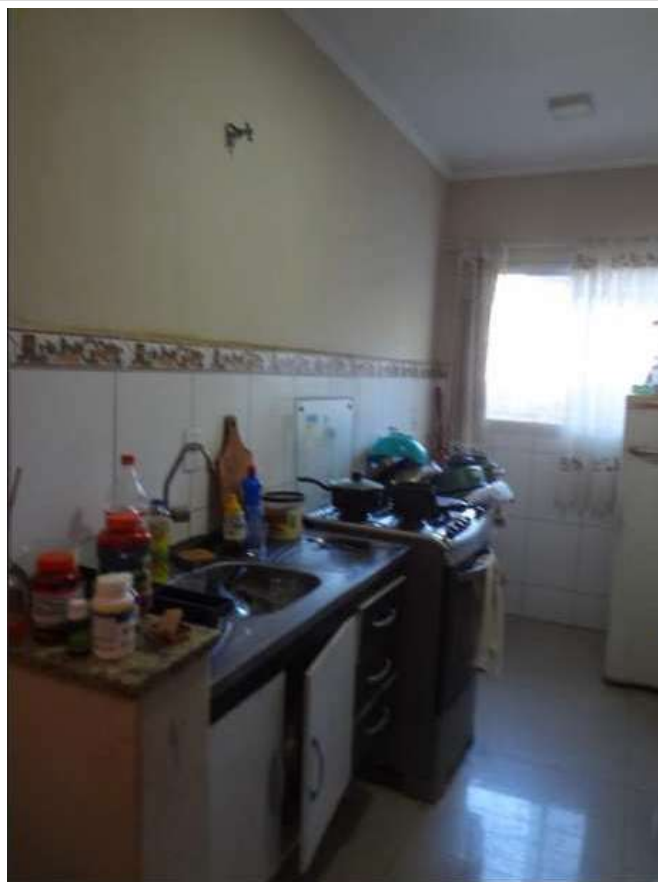
FOTO 48: Presença de pia e ½ mureta em alvenaria, recoberta por granito. Piso cerâmico.
