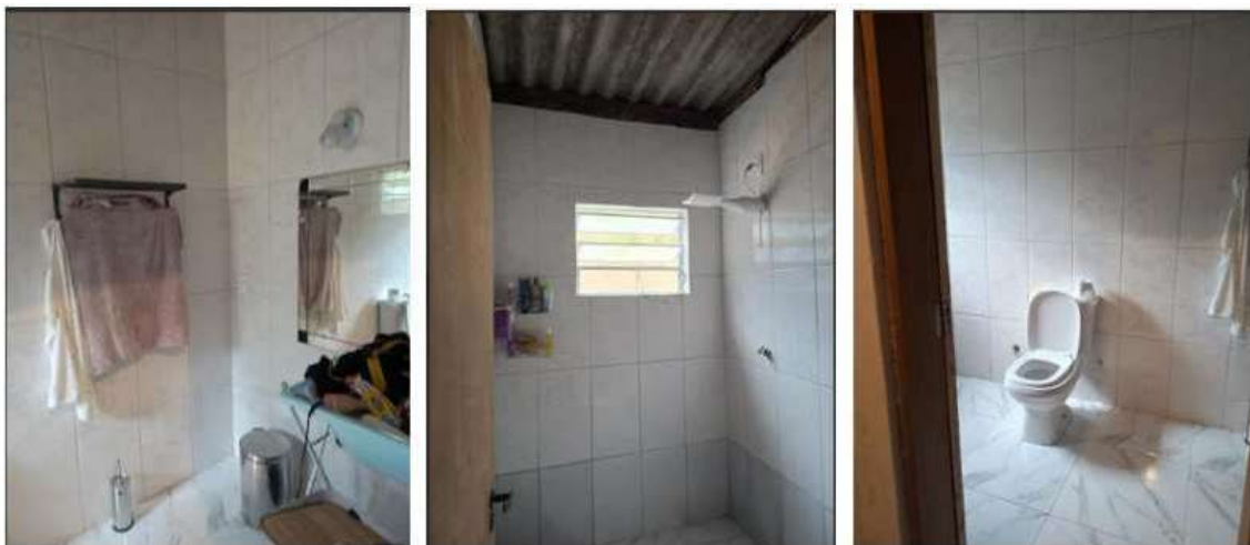
FOTO 83: Banheiro com revestimento cerâmico do piso ao teto. Louças e metais populares. Piso revestido por cerâmica.
