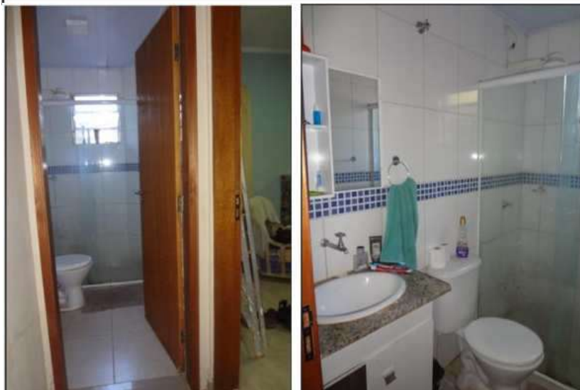
FOTO 49: Banheiro com revestimento cerâmico do piso ao teto. Louças e metais populares. Portas em madeira.
