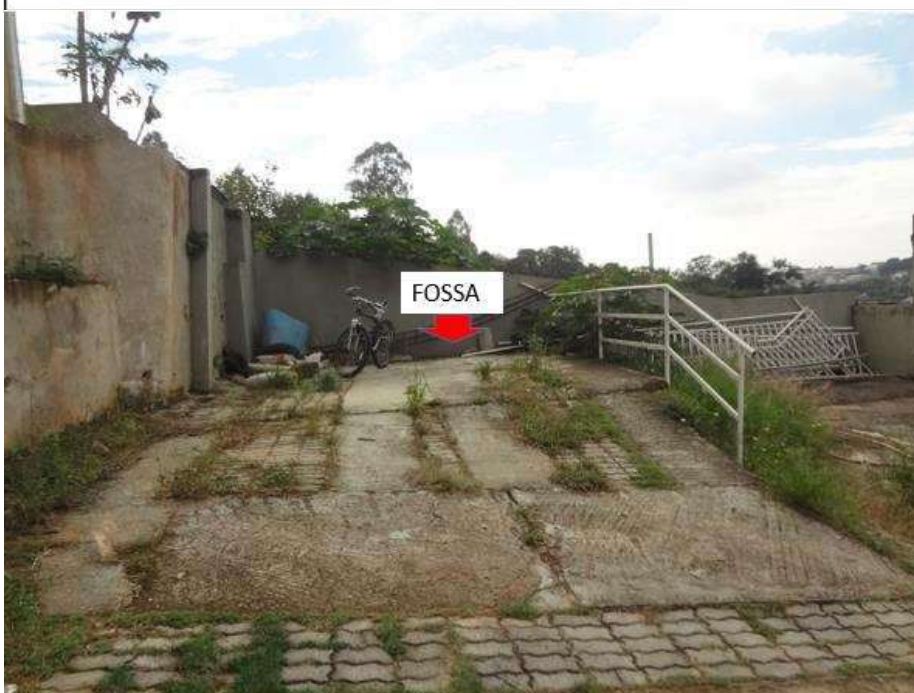
FOTO 35: Vista da área imediatamente frontal ao primeiro Bloco edificado. Presença de uma fossa, fechada. Não vistoriada.
