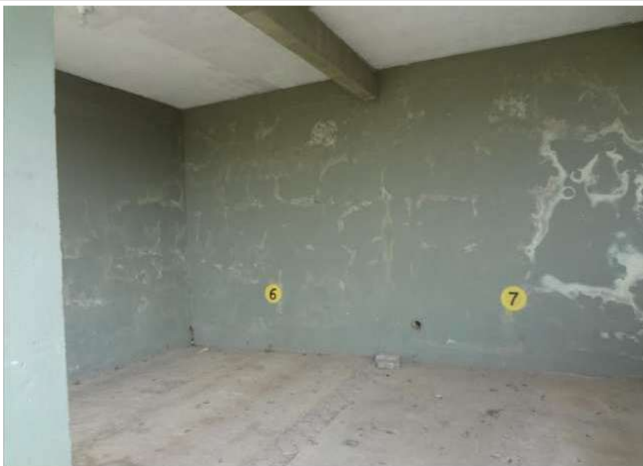
FOTO 40: Vista das vagas de garagem cuja parede de fundas confronta com a fossa de resíduos orgânicos do local.
