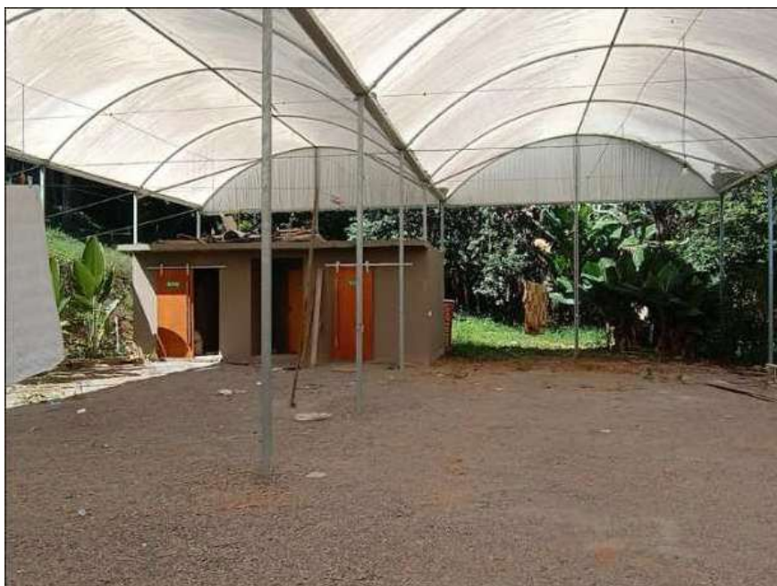
FOTO 71: Abaixo desta cobertura, estrutura de dois sanitários.
