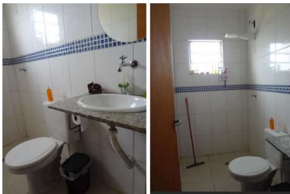
FOTO 57: Revestimento cerâmico do piso ao teto. Ausência de box. Louças e metais populares. Pia em granito.
