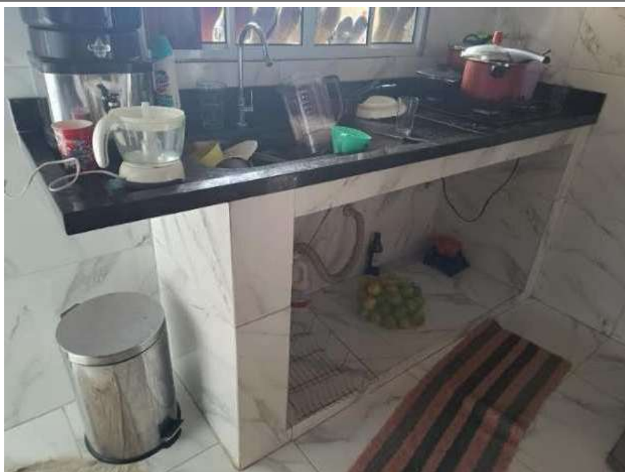
FOTO 79: Pia em granito. Ausência de gabinete. Metal popular. Piso cerâmico.
