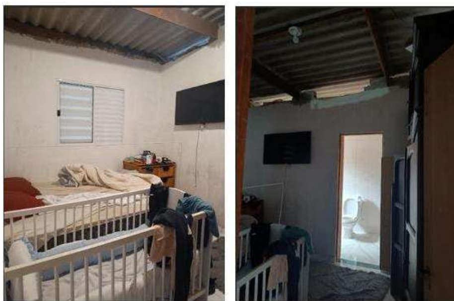
FOTO 82: Vista de um dos Quartos do imóvel. Presença de Banheiro privativo.
