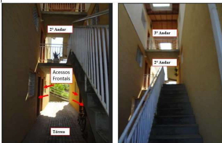
FOTO 43: Vista dos andares e dos acessos às Unidades de residências.
