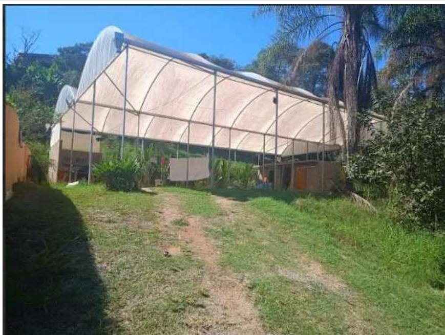
FOTO 70: Vista de uma estrutura metálica coberta de plástico de alta resistência.
