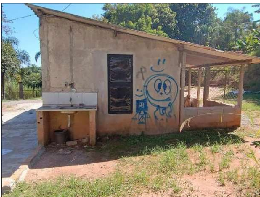
FOTO 75: Barraco de alvenaria depreciado pelo processo avaliatório. Não mostrado o interior.
