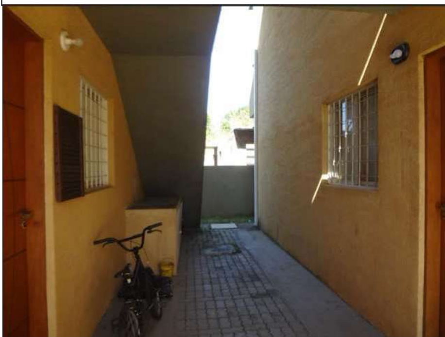
FOTO 45: Vista do corredor do piso térreo.
