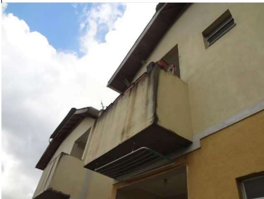
FOTO 29: Sacadas que acomodam as áreas de serviço externas.
