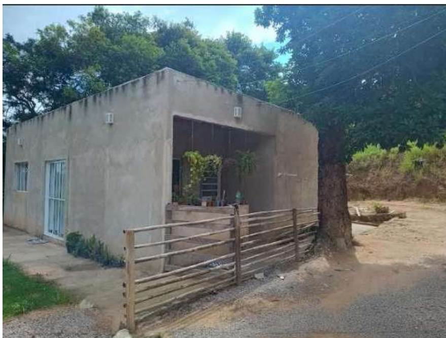
FOTO 77: Vista da área de serviço e da porta da Sala.
