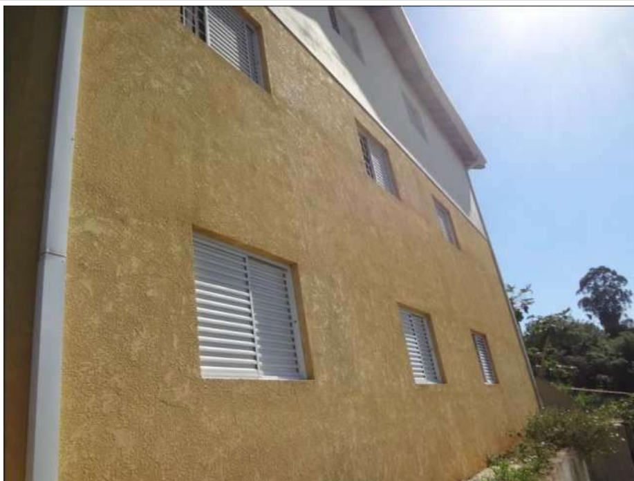
FOTO 28: Vista da fachada para a Rua Stepan Jauman.
