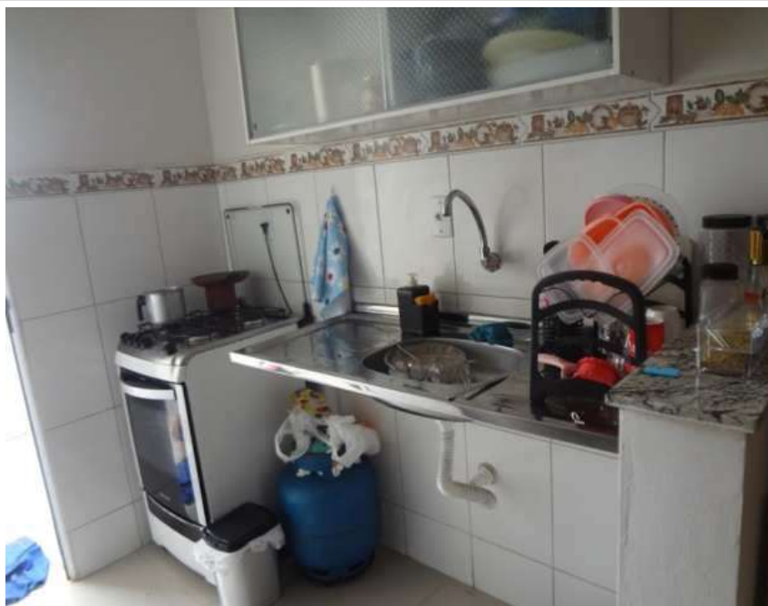
FOTO 54: Vista da Cozinha com revestimento cerâmico a ½ parede. Pia em inox. Metais populares. Mureta com revestimento em granito.
