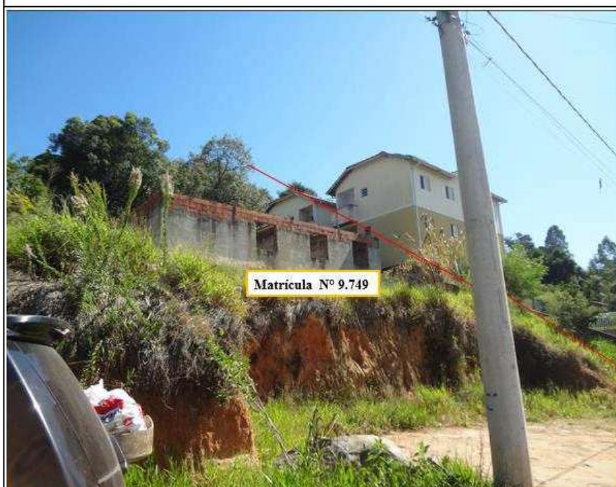
FOTO 07: Vista de uma construção, sem cobertura, na área periciada. CONSTRUÇÃO paralisada.
