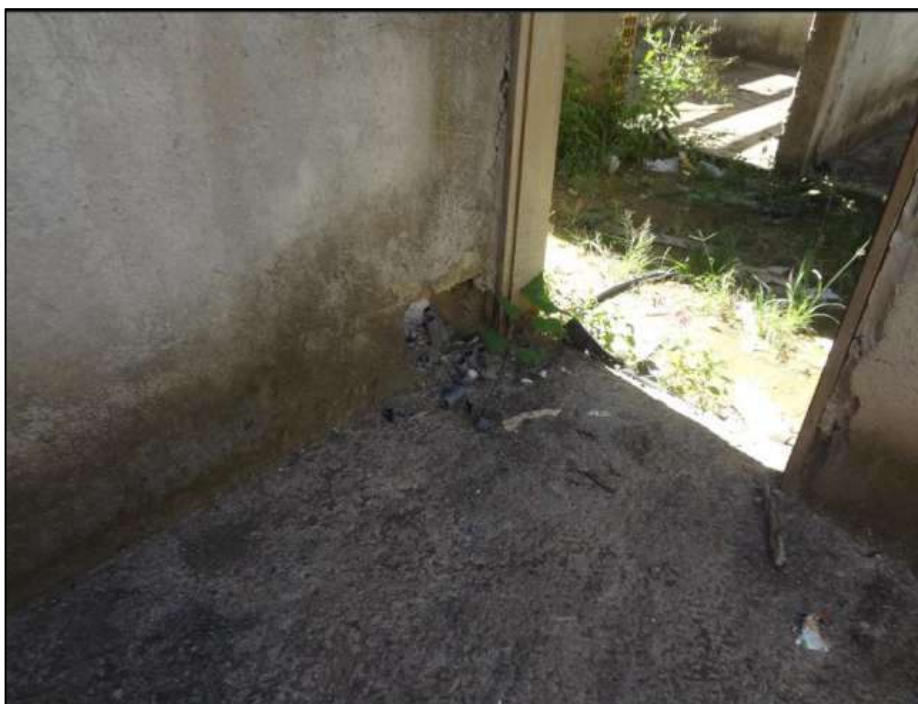
FOTO 20: Presença de conduítes inseridos no contra piso.
