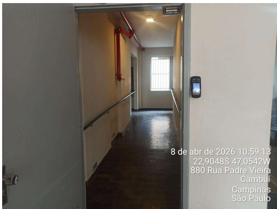
Foto 08 – Entrada de serviço do condomínio, localizada junto à área externa e ao acesso social.
