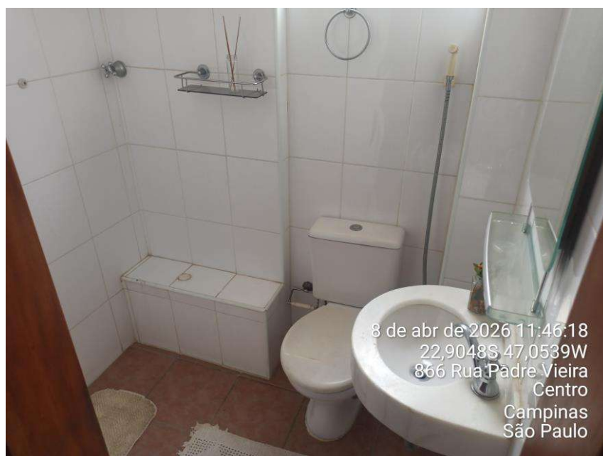
Foto 47 – Banheiro da área de serviços.
