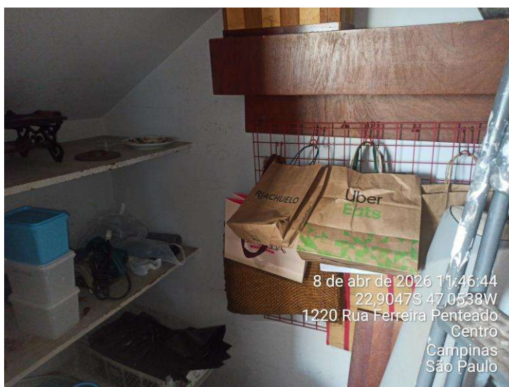
Foto 50 – Espaço em alvenaria sob a escada, adaptado como armário, localizado no quarto de serviço.
