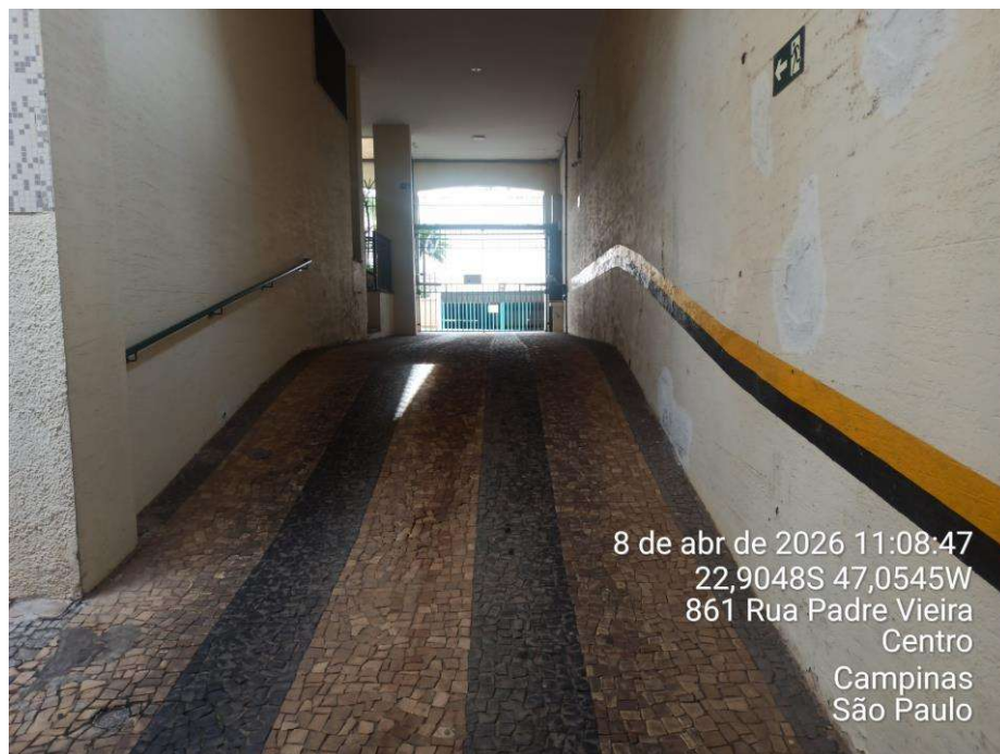
Foto 05 – Acesso a garagem piso inferior
