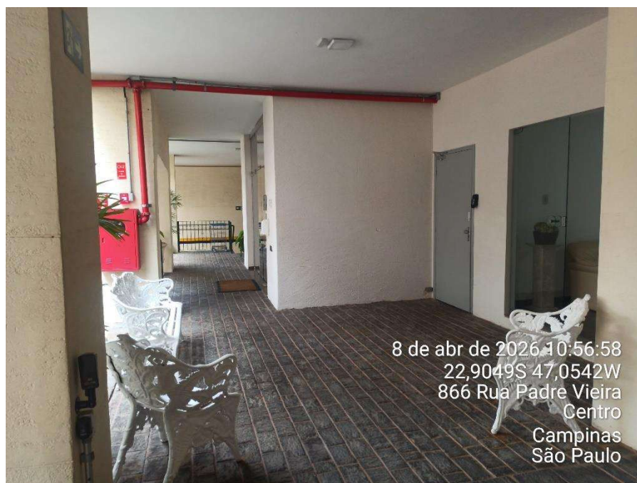
Foto 07 – Hall de entrada social do condomínio, com área de circulação comum.
