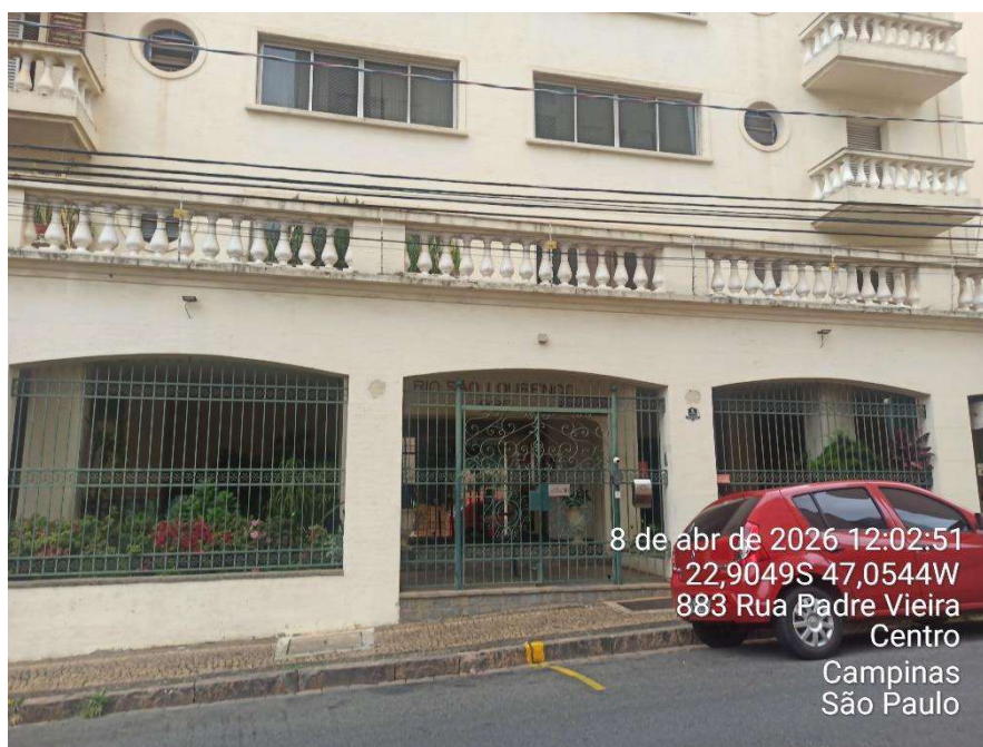
Foto 01 – Fachada do Prédio, entrada principal de pedestres.
