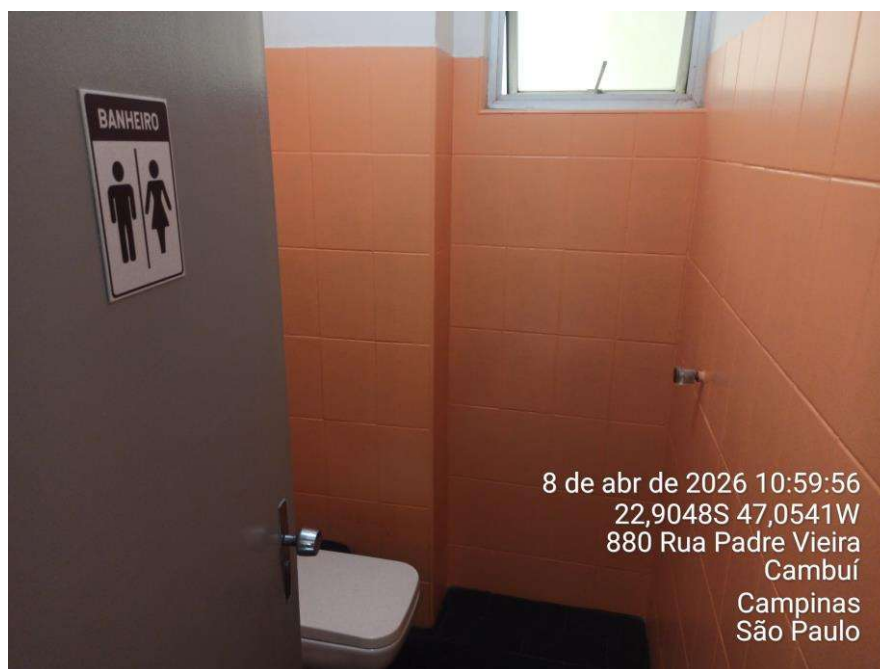
Foto 19 – Banheiro da área de serviço, com acesso à circulação do elevador de serviço.
