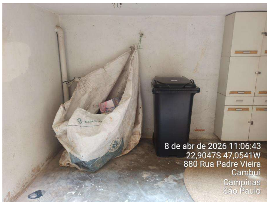
Foto 27 – Área destinada à coleta de resíduos recicláveis.
