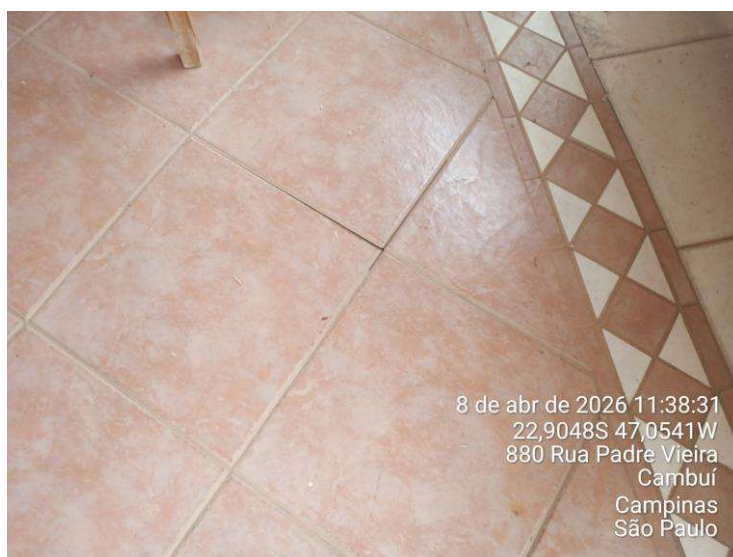
Foto 67 – Piso cerâmico no terraço coberto, apresentando estufamento, com indícios de descolamento das peças.
