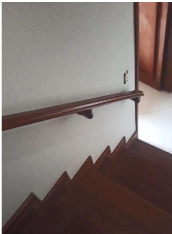
Foto 51 - Escada de acesso ao pavimento inferior, vista a partir do pavimento superior.
