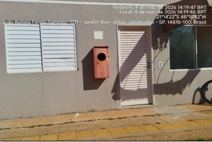
Fachada do Avaliando
